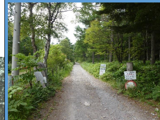
通行止箇所現地写真
